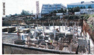
Radovi na zgradi buduće Sveučilišne knjižnice
